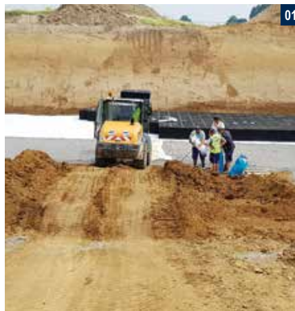
01 Planum und erster Bauabschnitte mit Geomembrane und ENREGIS/X-Box ® 02 Vorbereitung für den zweiten Bauabschnitt des ENREGIS Rigolensystems 03 Entlüftung und Inspektionskanäle sind bereits integriert, Vorbereitungen für die nächste Stufe 04 Innenansicht der ENREGIS-typischen vollintegralen Sedimentations-, Filter- und Rückspülstufe
