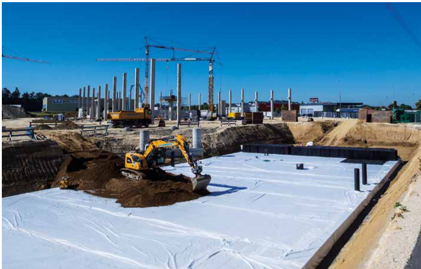
Stufenweiser Einbau der ENREGIS Systemkomponenten bei gleichzeitigem Aufbringen der Überdeckung
