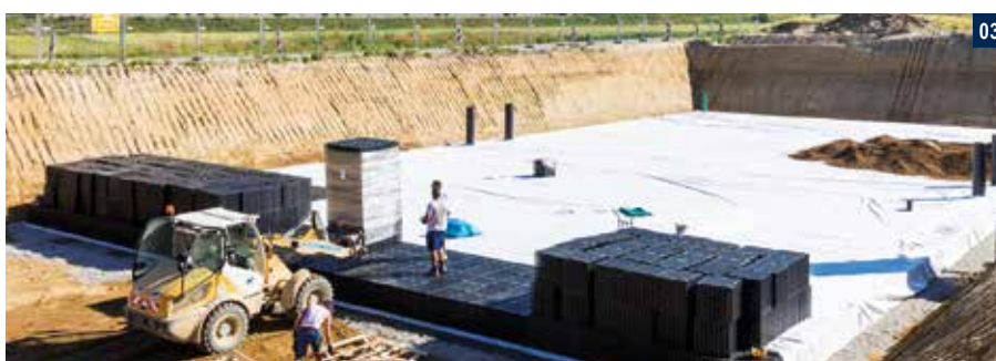
01 Planum und erster Bauabschnitte mit Geomembrane und ENREGIS/X-Box ® 02 Vorbereitung für den zweiten Bauabschnitt des ENREGIS Rigolensystems 03 Entlüftung und Inspektionskanäle sind bereits integriert, Vorbereitungen für die nächste Stufe 04 Innenansicht der ENREGIS-typischen vollintegralen Sedimentations-, Filter- und Rückspülstufe
