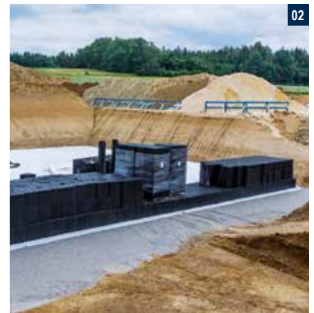
01 Planum und erster Bauabschnitte mit Geomembrane und ENREGIS/X-Box ® 02 Vorbereitung für den zweiten Bauabschnitt des ENREGIS Rigolensystems 03 Entlüftung und Inspektionskanäle sind bereits integriert, Vorbereitungen für die nächste Stufe 04 Innenansicht der ENREGIS-typischen vollintegralen Sedimentations-, Filter- und Rückspülstufe
