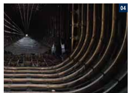
01 Planum und erster Bauabschnitte mit Geomembrane und ENREGIS/X-Box ® 02 Vorbereitung für den zweiten Bauabschnitt des ENREGIS Rigolensystems 03 Entlüftung und Inspektionskanäle sind bereits integriert, Vorbereitungen für die nächste Stufe 04 Innenansicht der ENREGIS-typischen vollintegralen Sedimentations-, Filter- und Rückspülstufe
