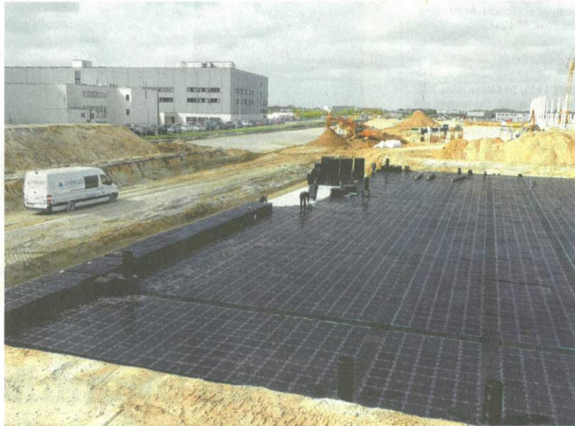
Gigantische Ausmaße: Auch Großprojekte wie Regenwasserbewirtschaftung auf 60 000 Quadratmetern Fläche, hier im Bereich Gewerbe-/Logistikbau für eine Firma in Großburgwedel bei Hannover, stemmt die Enregis GmbH. FOTO: ENREGIS
