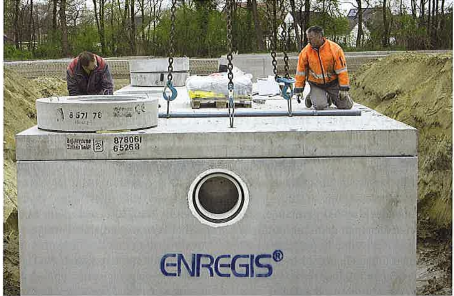
Stromwater Management: Das Foto zeigt den Einbau eines Lamellenklärsers BV bei einem Leuchtenhersteller in Lippstadt.
