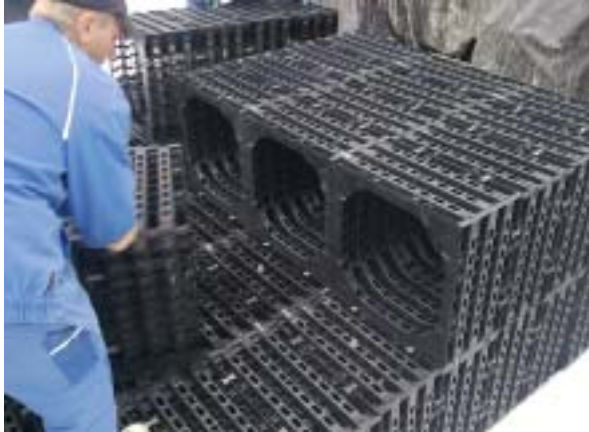
Bild 2. Die problemlose Modulverlegung ermöglicht eine kurze Bauphase.
