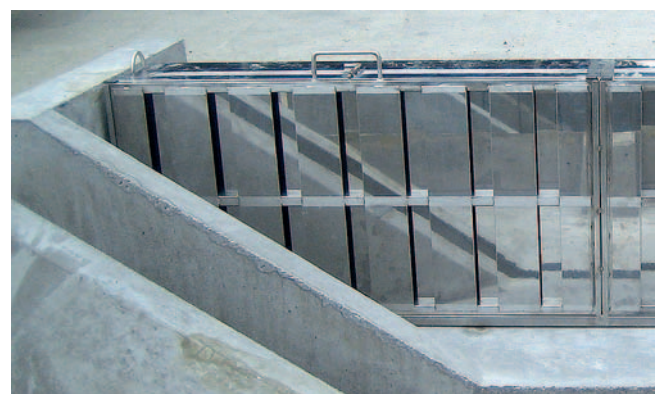
Envia-TRP-System: Reinigungsstufe im Zulauf eines kommunalen Regenwasser-Vorfluters. Fotos und Grafik: Enregis
