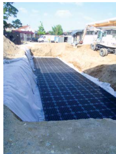
Einbau des 20 cm starken Substratträgersystems Enregis/X-Box.
