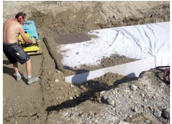
Lagenweise Verdichtung der Rigolenanlage.
