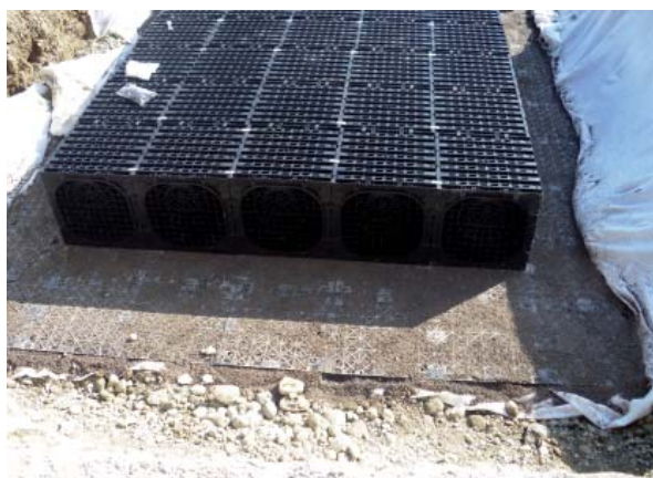
Rückhaltung über der Biofiltrationsstufe.
