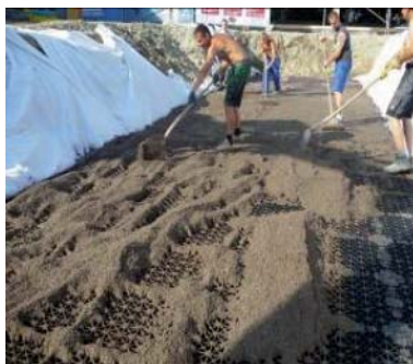
Vollflächige Verteilung und Einbringung des Biofiltrationssubstrates.
