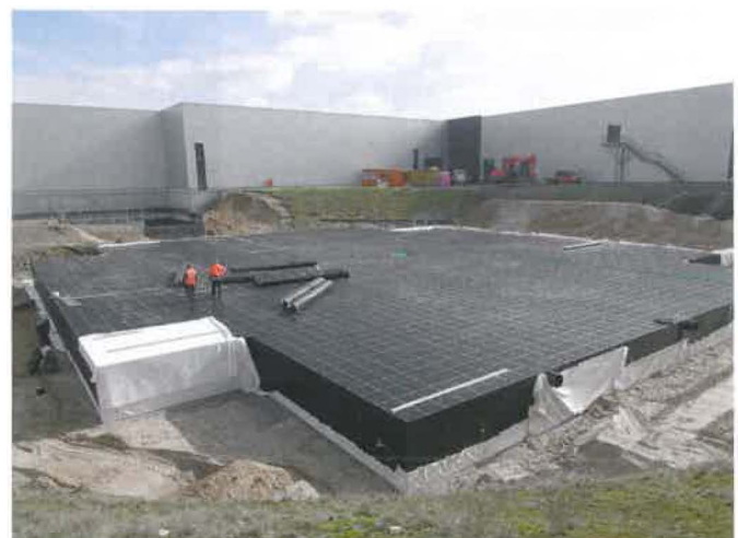
Überblick über die gesamte Anlage
