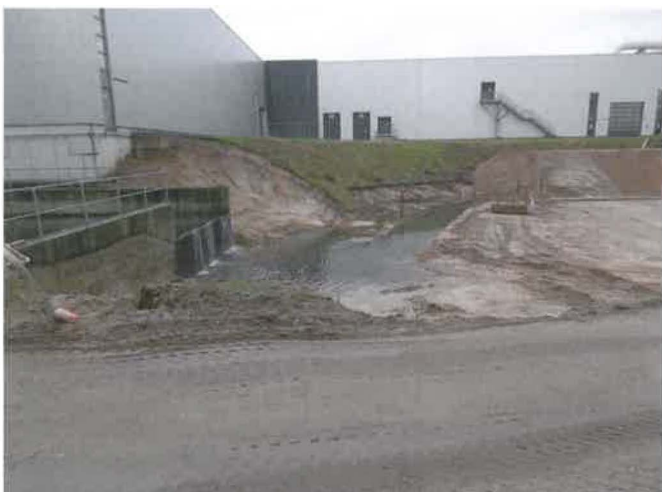
Vorbereitende Maßnahme zur Wasserhaltung für das Planum der Retentionsanlage
