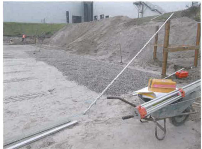
Erstellung des Planums und der Ausgleichsschicht nach Vorgaben des Herstellers- bzw. DIBt
