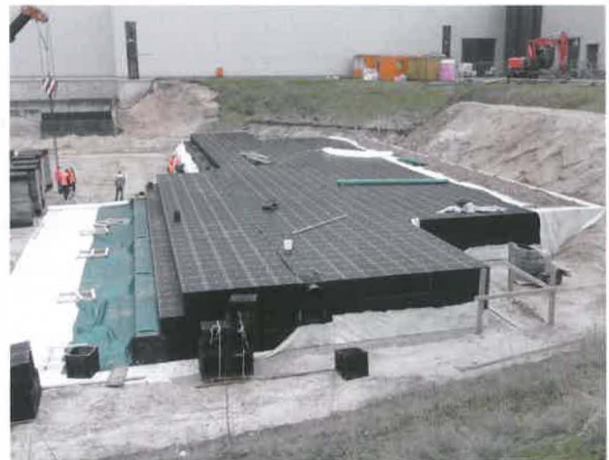
Einbau des DIBt-zugelassenen ENREGIS Retentionssystems
