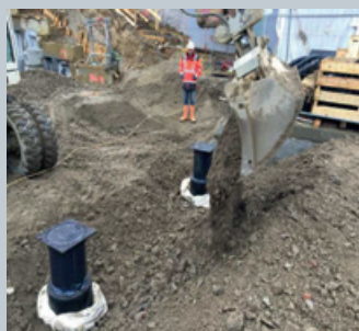
Lageweises Hinterfüllen sowie Verdichten mit nicht bindigem Erdmaterial bzw. Schotter
