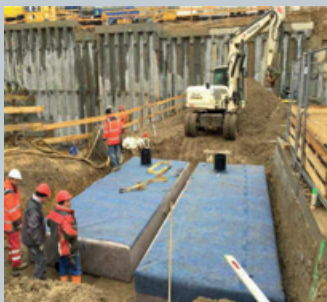
Rasches und einfaches Versetzen, sofort nach Anlieferung
