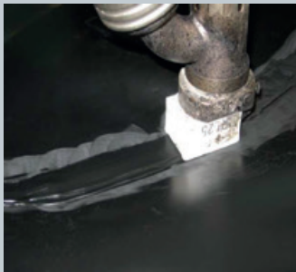
Verschweißen der 2 mm PE-HD Folie
