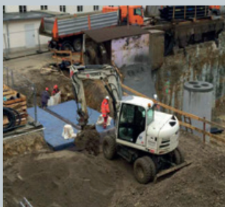
Lageweises Hinterfüllen sowie Verdichten mit nicht bindigem Erdmaterial bzw. Schotter
