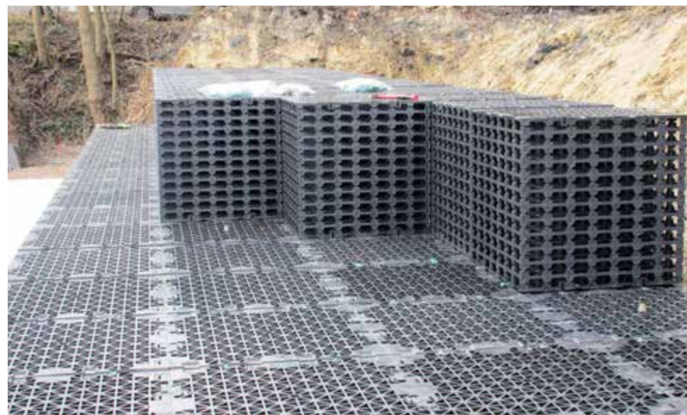
Retentionsanlage im Aufbau
