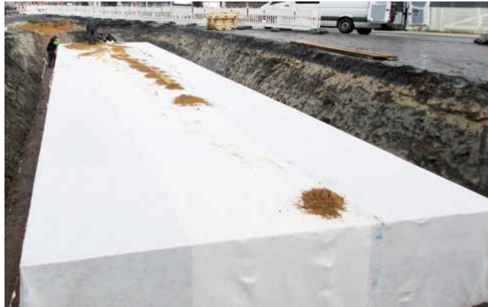
Retentionsanlage eingehaust mit Filtervlies vor der Verfüllung
