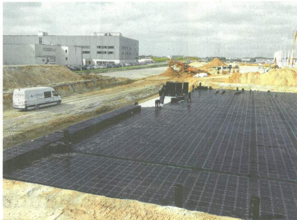
Gigantische Ausmaße: Auch Großprojekte wie Regenwasserbewirtschaftung auf 60 000 Quadratmetern Fläche, hier im Bereich Gewerbe-/Logistikbau für eine Firma in Großburgwedel bei Hannover, stemmt die Enregis GmbH. FOTO: ENREGIS
