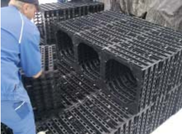
Bild 2. Die problemlose Modulverlegung ermöglicht eine kurze Bauphase.
