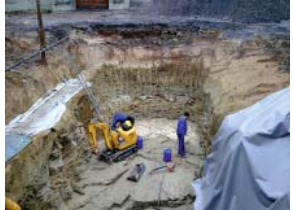
Bild 3. Die örtliche Geologie erforderte ein Vordringen bis auf zerklüftetes Feld in 6 m Tiefe.
