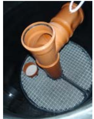
Bild 7. Zweite Reinigungsstufe: Wartungs- und kostenoptimierter Schwermetalladsorptionsfilterschicht mit dem Hochleistungssubstrat Biocalith K.
